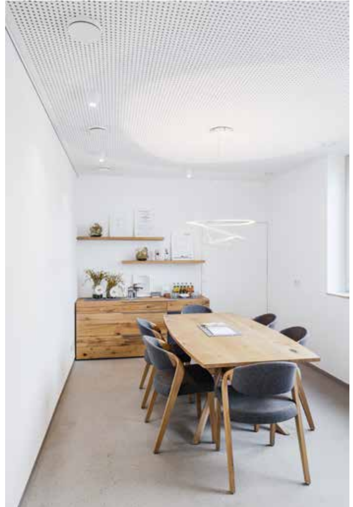
Durch die auf Maß gefertigte Zehnder Gipskartondecke in gelochter Ausführung werden Geräusche stark gedämmt – ideal für das Besprechungszimmer.
