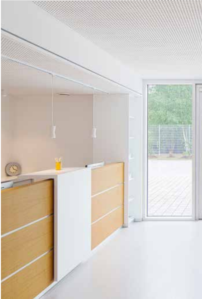
Die perforierte Gipskartondecke von Zehnder fügt sich optisch ansprechend in den Empfangsbereich der Jäger Haustechnik ein. Das ganze Jahr über kann damit in einem einzigen System geheizt und zugluftfrei gekühlt werden.
